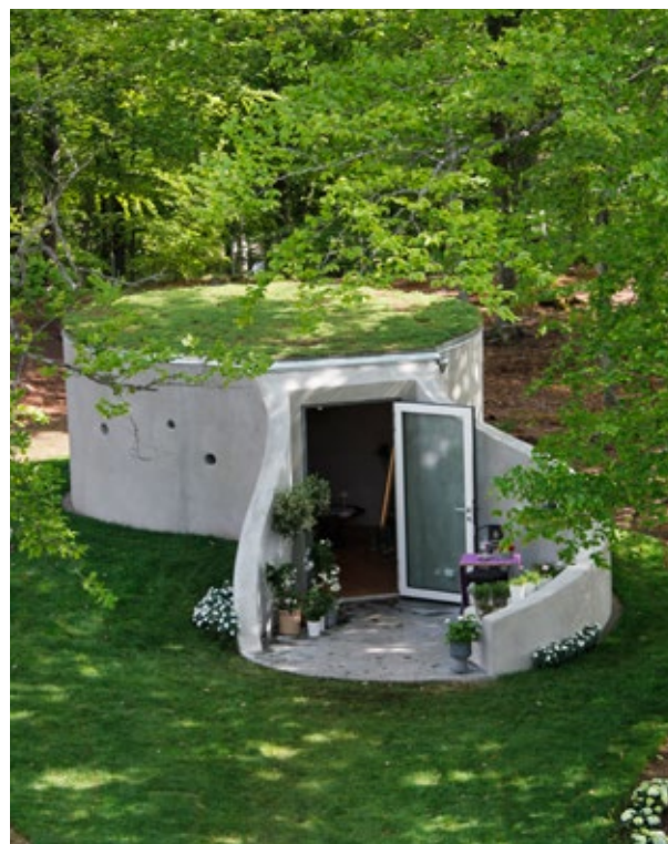
Fasadputsens vitpigmenterad för att ljusa upp betongens naturliga färg.
