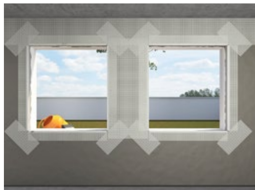
Montera glasfibervinklar och näta diagonalt runt samtliga hörn enligt tidigare.
