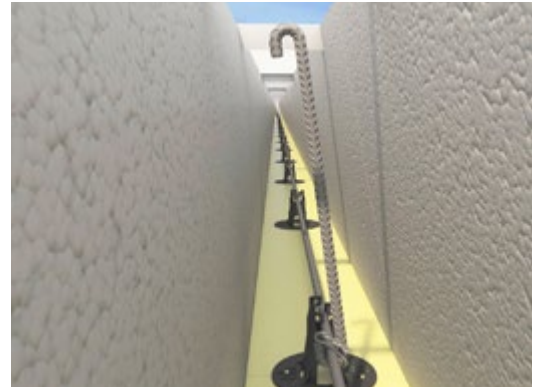
Bygel 2 håller samman de två längsgående armeringsjärnen i den yttre betongbalken.
