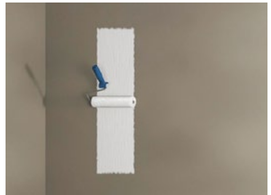
Silikatfärg kan lätt appliceras med roller.
