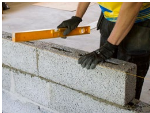
Innerväggarna muras med Finja Murbruk B och Finja Murblock Fördel ECO och Murblock Bas 90/Passblock 190.
