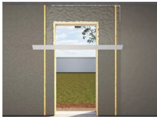
Putsa invändigt med avdragsbanor på samma sätt som på fasaden.
